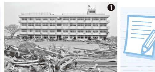
① 被災現場の様子
